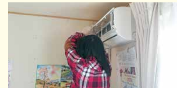
仮設住宅内のエアコンのフィルター清掃(2014年12月)
