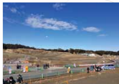
いわき市薄磯地区。土地区画整理事業により高台・嵩上げ地が造成されている。果たしてそこに何世帯が再建するか?(2016年2月)
