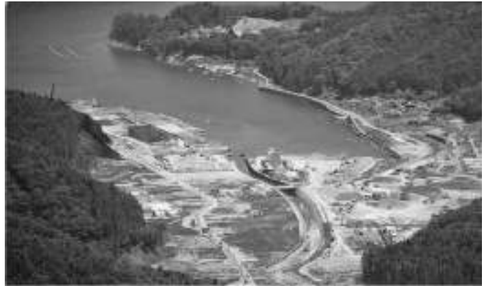
写真 3-3-1 雄勝町雄勝地区の被害風景
