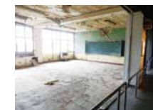
震災遺構 仙台市立 荒浜小学校 宮城県仙台市 2017年4月 公開開始
