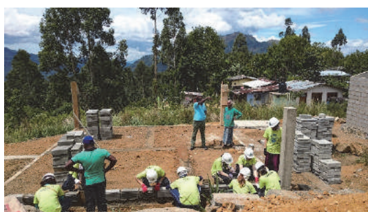
【写真】スリランカでの建築ボランティアの様子
